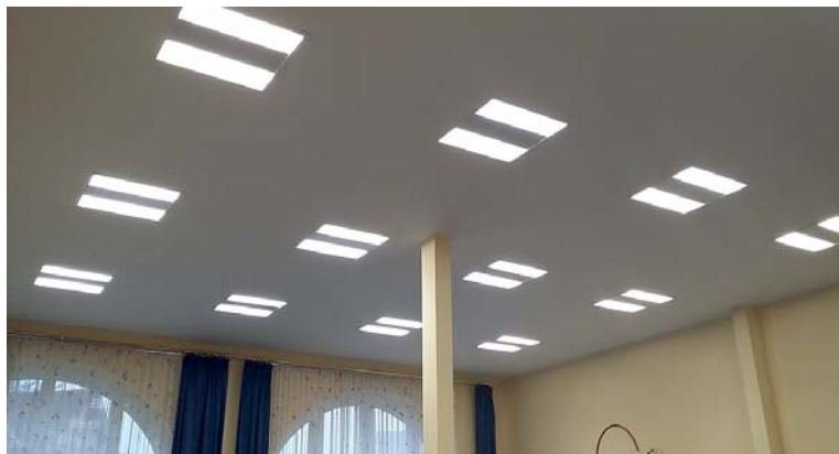
↑ Zde byla provedena výměna zářivkových světel za nová s LED zdroji
