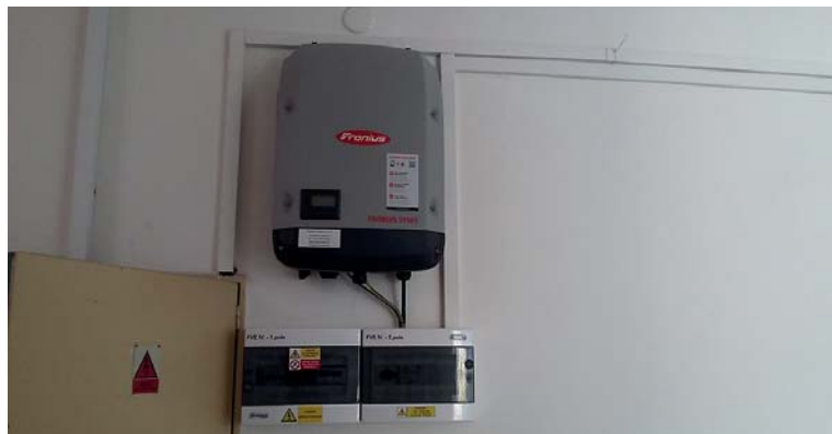
↑ Střídač Fronius Symo 3 pro fotovoltaická zařízení připojená k síti
